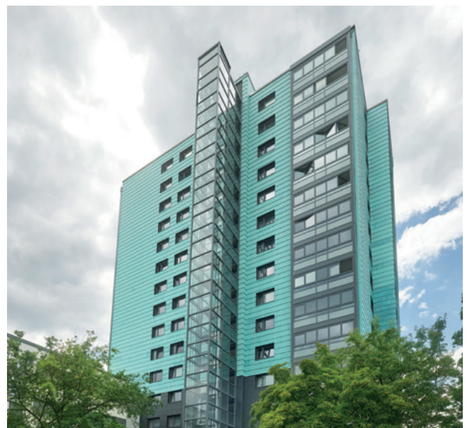
Wohnhaussanierung (Duitsland) - Bedrijf: Rold Kleinfeld GmbH - Aspect: Nordic Blue Living 3
